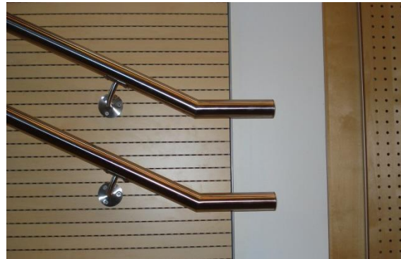
Mynd 6. Dæmi um handlista 0,3 m fram fyrir neðsta þrep. Hér þarf að ganga betur frá endum handlista til að forðast slys
