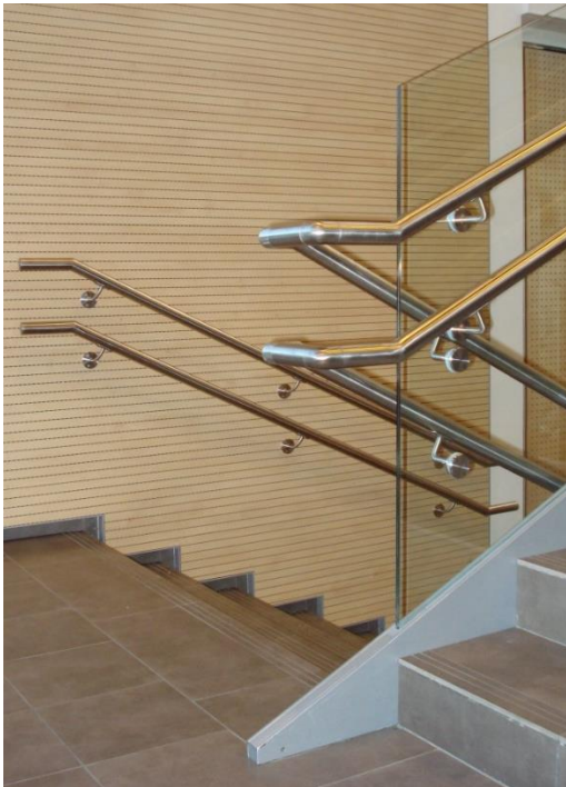
Mynd 5. Dæmi um óslitinn handlista utan um ljósop og handlista 0,3 m fram fyrir efsta og neðsta þrep þar sem dyr liggja að stigapalli og utan um ljósop
