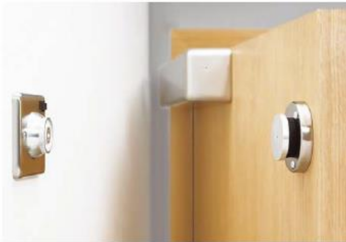
Mynd 6. Segulgrip á hurð. Mynd fengin úr Code of Practice: Hardware for Fire and Escape Doors
