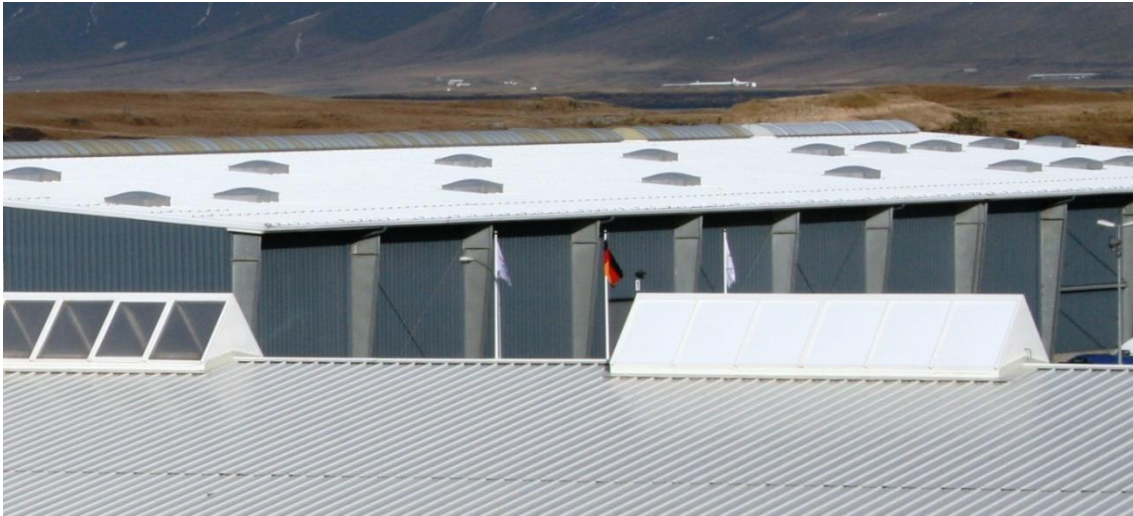
Mynd 1. Dæmi um mismunandi fyrirkomulag reyklosunar.
