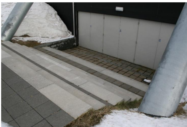
Mynd 3. Dæmi um flóttaleið þar sem flæði getur verið skert vegna trappa sem hægja á ferð fólks.
